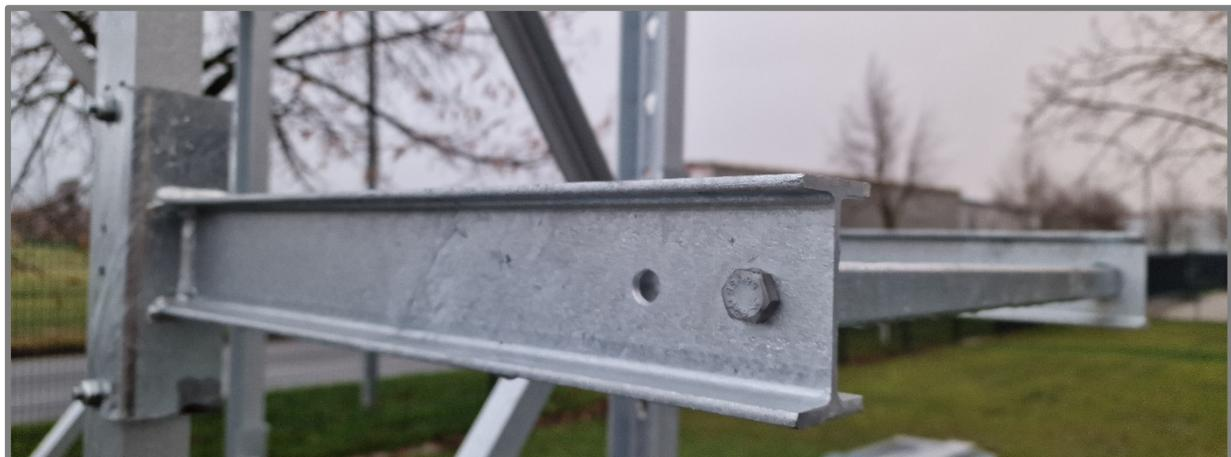
4. Hängen Sie - sofern vorhanden - die **Kragarme IPE 80, 500 mm** nach dem gleichen Prinzip wie die Regaltraversen auf die gewünschte Höhe in die Rahmen. Verbinden Sie diese anschließend mit den **Zugrohren**, sowie **Schrauben M12x40 mm + Unterlegscheiben 13x2 mm** untereinander. Hängen Sie anschließend die entspr. **Gitterroste(n)** ein.
