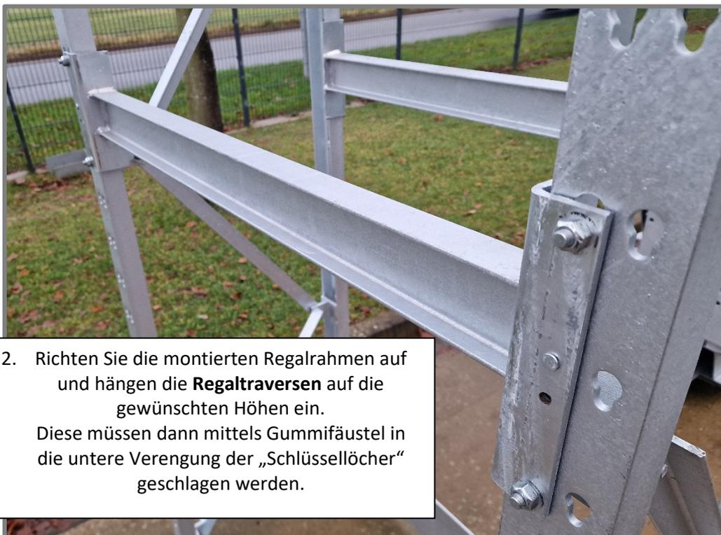
2. Richten Sie die montierten Regalrahmen auf und hängen die **Regaltraversen** auf die gewünschten Höhen ein. Diese müssen dann mittels Gummifäustel in die untere Verengung der „Schlüssellöcher“ geschlagen werden.
