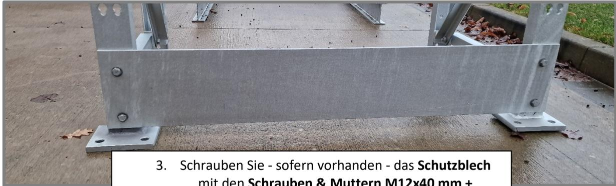
3. Schrauben Sie - sofern vorhanden - das **Schutzblech** mit den **Schrauben & Muttern M12x40 mm + Unterlegscheiben 13x2 mm** an die hinteren Rahmenstangen.
