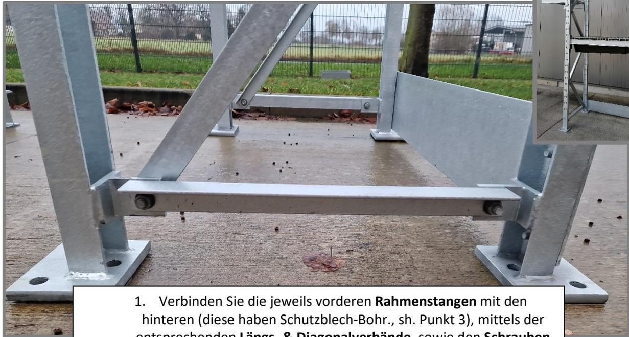
1. Verbinden Sie die jeweils vorderen **Rahmenstangen** mit den hinteren (diese haben Schutzblech-Bohr., sh. Punkt 3), mittels der entsprechenden **Längs- & Diagonalverbände**, sowie den **Schrauben & Muttern M12x40 mm + Unterlegscheiben 13x2 mm**.
